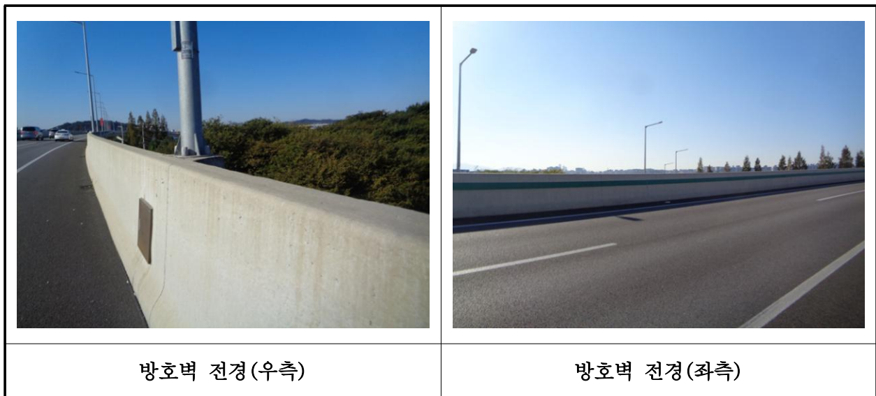
【사진 16.3.23】 방호벽 전경
