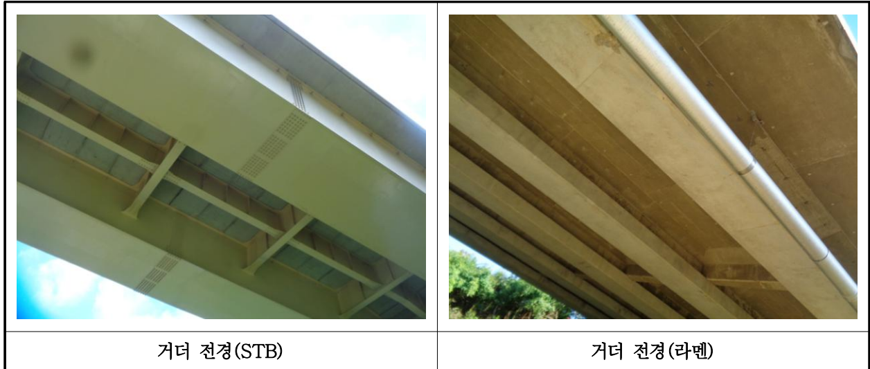
【사진 16.3.4】 거더 전경
