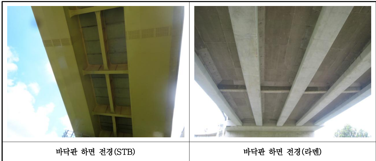
【사진 16.3.2】 바닥판하면 전경
