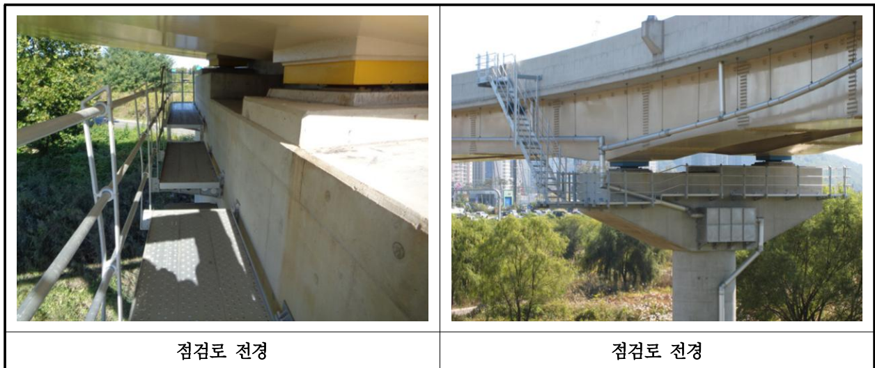
【사진 16.3.25】 교량 점검시설 전경
