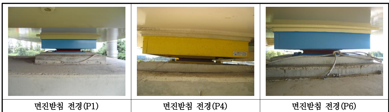
【사진 16.3.12】 교량받침 전경
