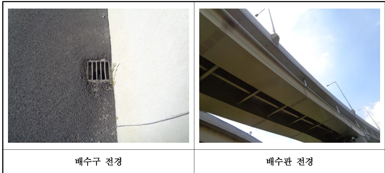
【사진 16.3.21】 배수시설 전경
