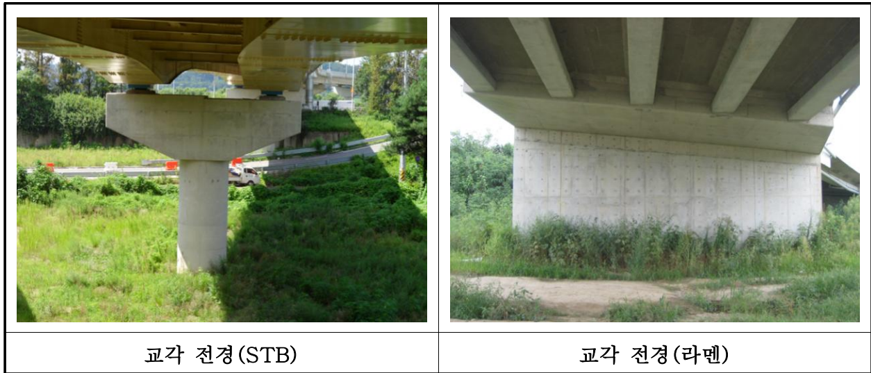
【사진 16.3.10】 교각 전경
