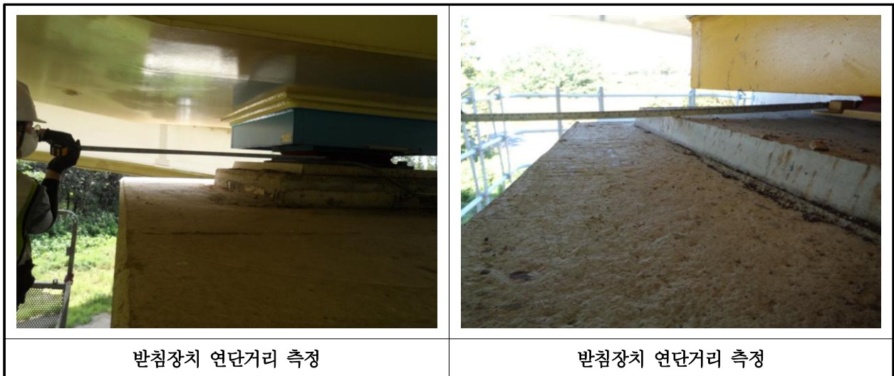
【사진 16.3.14】 교량받침장치 연단거리측정
