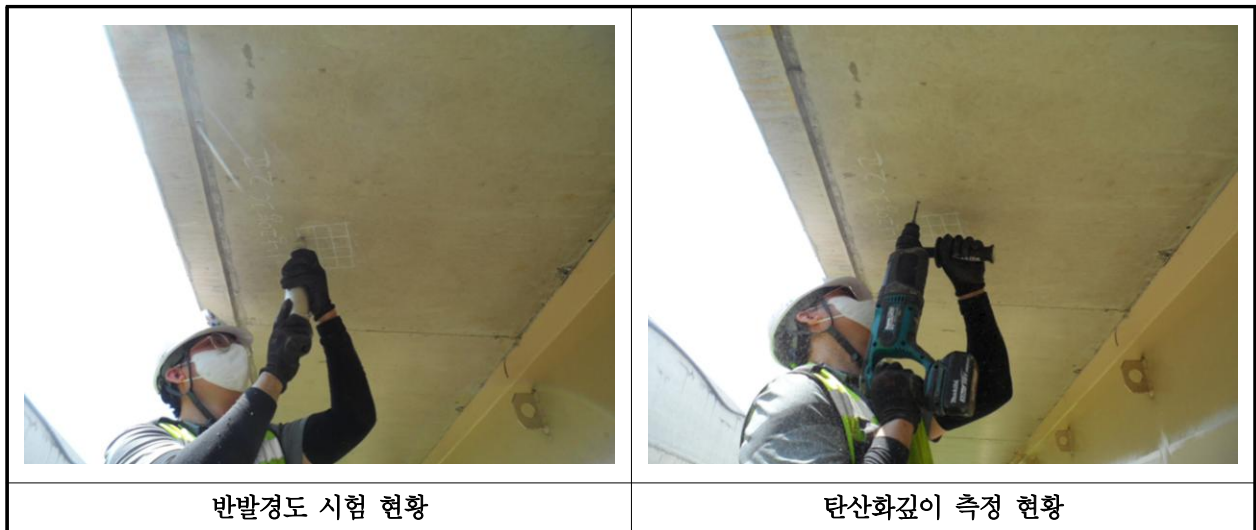
【사진 16.4.1】 콘크리트 내구성조사 현황
