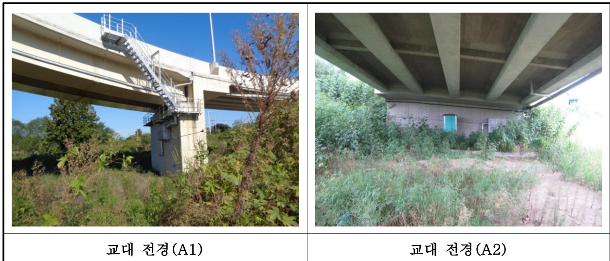
【사진 16.3.8】 교대 전경
