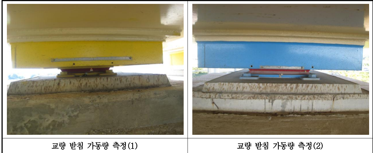
【사진 16.3.15】 교량받침 이동량 측정
